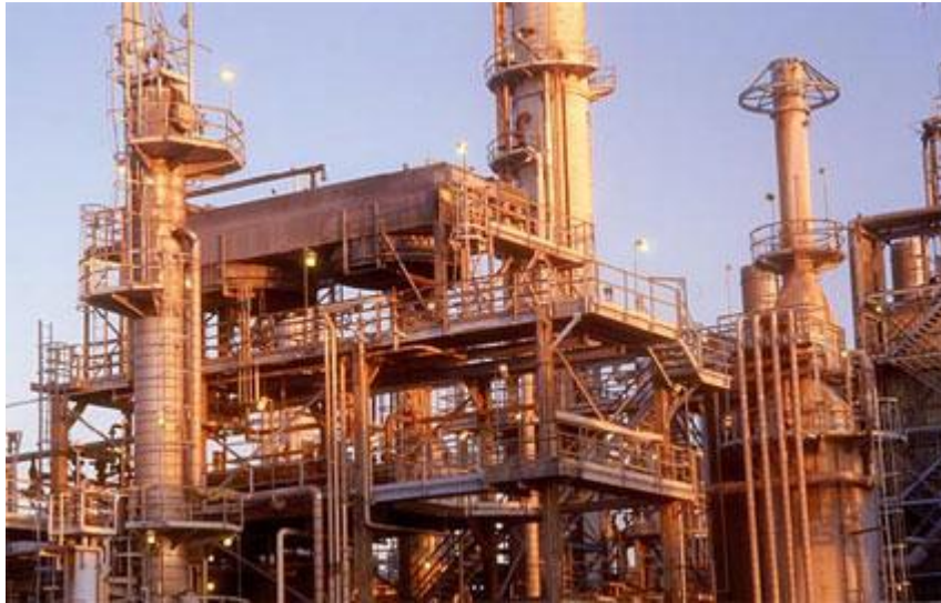
Refineria de petroli
