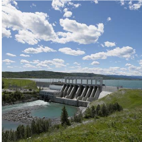
Vista d'una presa amb central hidroelèctrica (part esquerra)
