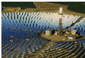
Panells d'energia solar. En la part central, s'observa el col·lector d'energia, cap al qual es dirigeixen tots els panells.
